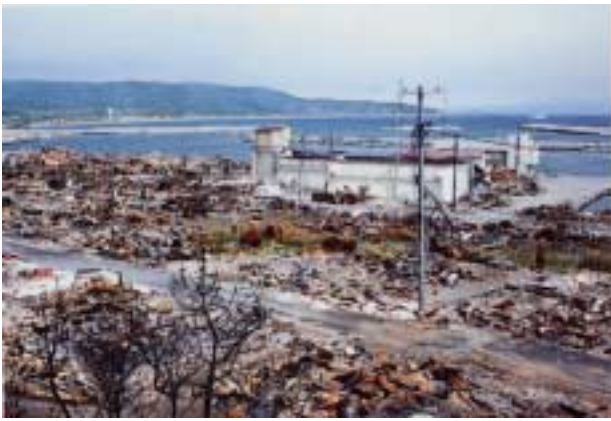
写真 8 1993 年北海道南西沖地震で地震にも津浪にも火災にも負けずに残った R C ビル。
