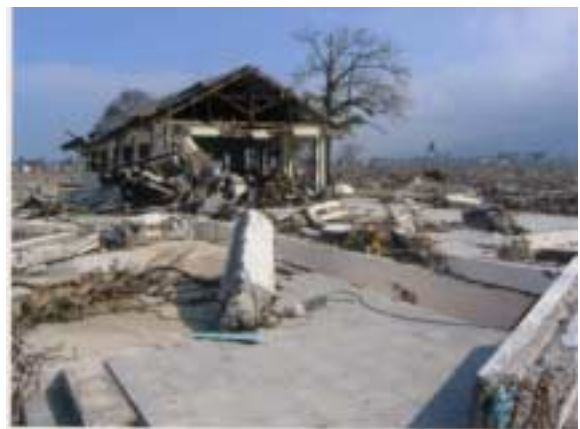
写真1 バンダアチェ市街地のRC建物の崩壊。
