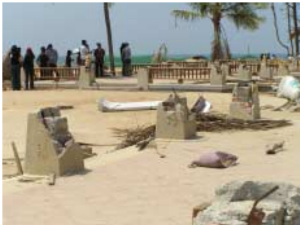
写真6、写真5のクローズアップ、1本鉄筋。
