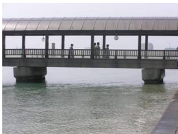
写真-3 詳細被害状況(海の中道の栈橋)
