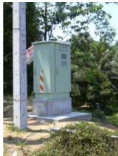
図-41 Pak Veep での交換盤設置後の様子
