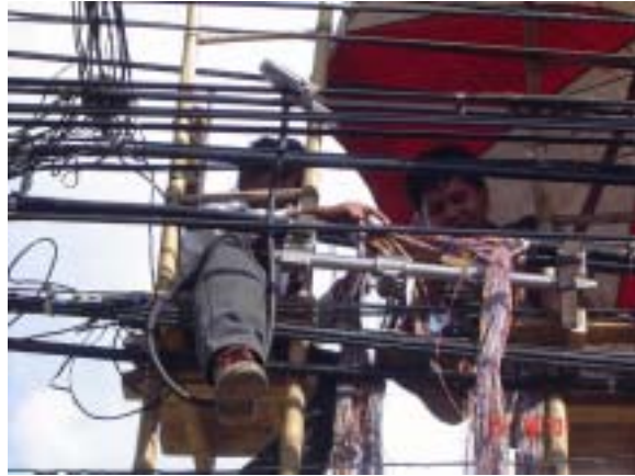
図-38 復旧工事の様子
