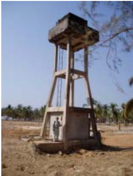
図-10 Khuk Kak 周辺の配水塔（周辺の建物はなくなり塔だけが残っている）
