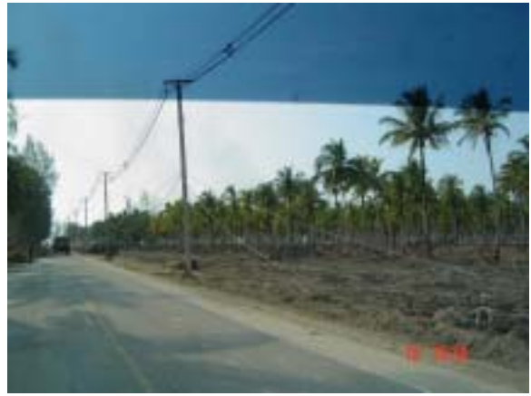
図-36 通信ケーブルの被害
