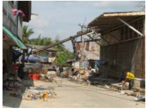
図-26 電柱の倒壊
