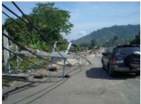
図-24 電柱の倒壊
