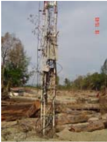
図-37 通信施設の被害
