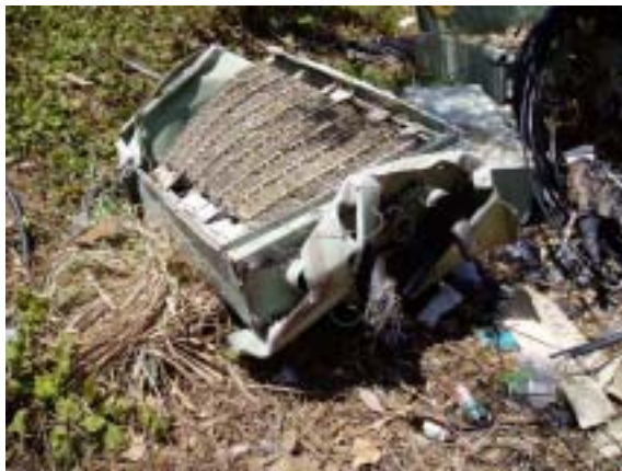
図-31 電柱の倒壊
