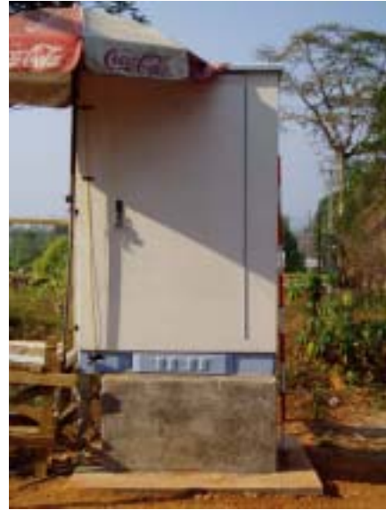
図-43 Bang la on での交換盤設置後の様子
