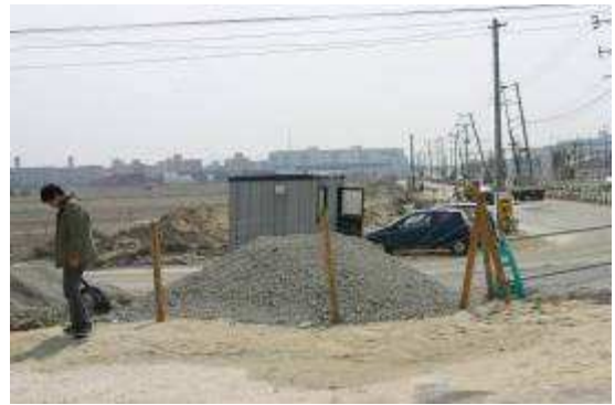
写真-7 アイランドシティでの噴砂跡
