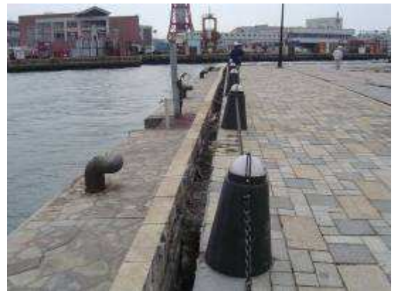
写真-26 中央埠頭イベントバースでの地盤の流動
