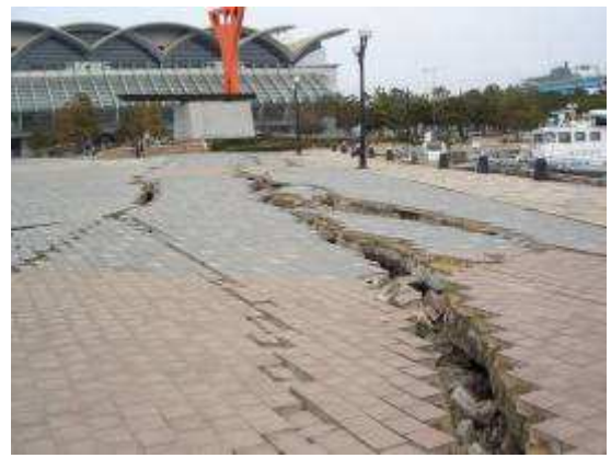
写真-25 中央埠頭イベントバースでの地盤の流動
