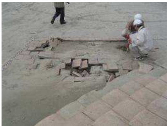
写真-5 中央埠頭イベントバスでの噴砂跡
