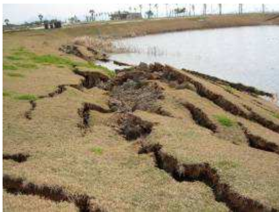
写真-24 海の中道海浜公園（光と風の広場）内での地盤の流動
