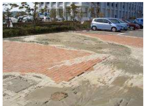
写真-2 百道浜 Panasonic 駐車場での噴砂跡
