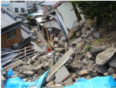
写真-2 家屋・宅地崩壊による道路閉塞
