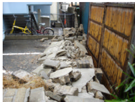
写真-8 ブロック塀の崩壊
