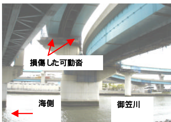
写真-6 支承が破損した曲線桁橋
