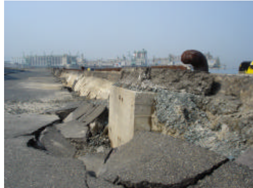
写真-4 中央埠頭における埠頭の被害
