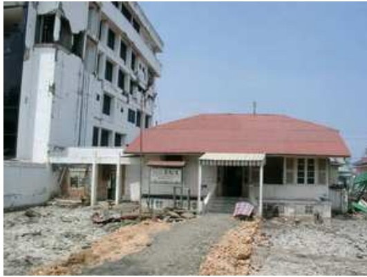
図-4 大きく被災した RC 構造物と、それに接する木造家屋（ホテル）
