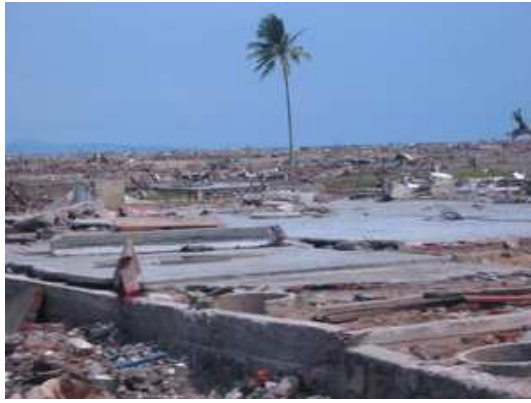
図-8 RC 構造物の基礎は残っているが、柱は見当たらない。木造構造物は流出してしまっている（地区 F 東側の沿岸部にて）
