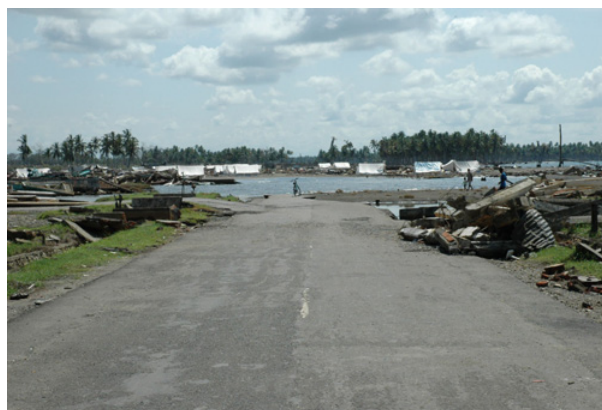
図-8 海岸線道路の寸断状況(Kuala Bobon)：被災前は道路が続いていた(図-9の十字路付近)。
