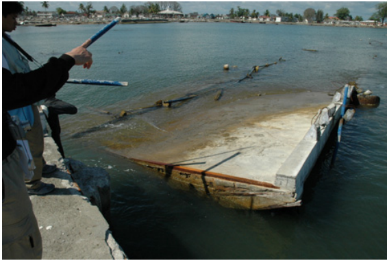
図-12 フェリー栈橋の流失(Ujount Kalang)
