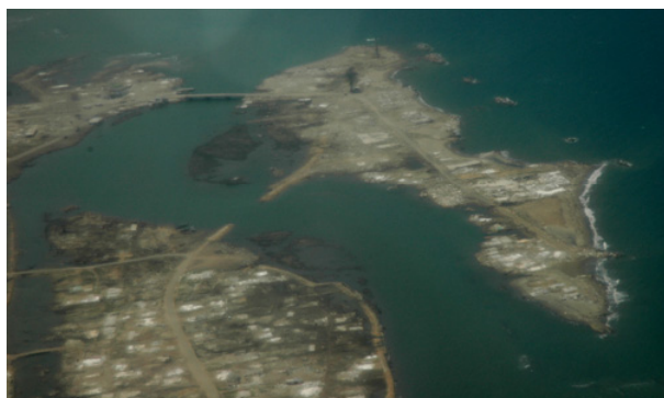
図-3 ウリーリー地区の海岸線消失状況
