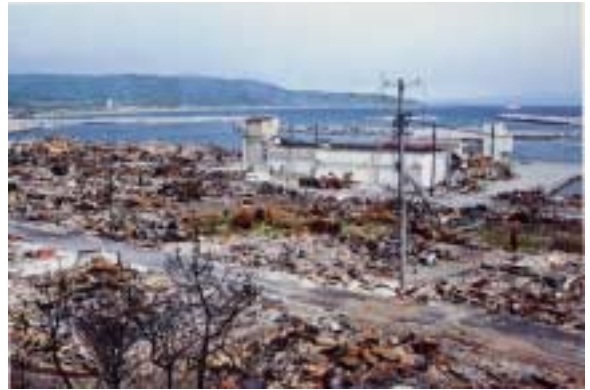
写真2 1993年北海道南西沖地震において、地震、津波、火災に耐えて唯一残った鉄筋コンクリートビル。
