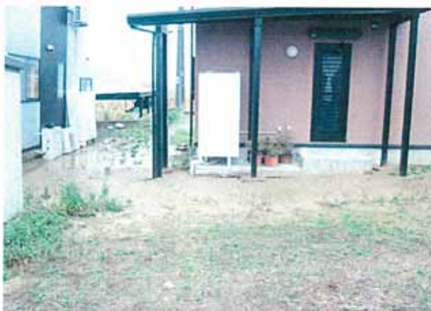
写真-2 液状化による噴砂現象
