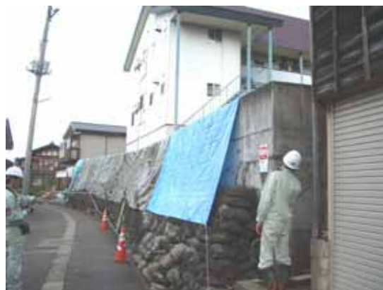
写真-2 宅地擁壁の被災度判定状況 (十日町市)
