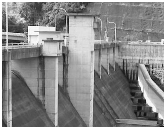
図-4 ダム頂とエレベータ塔の外観
