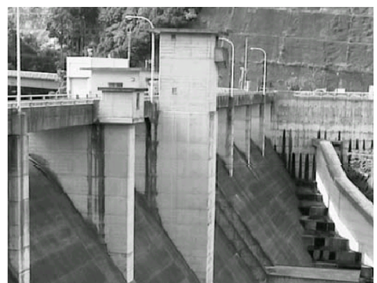
図-4 賀祥ダムエレベータシャフト
