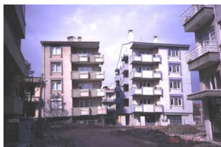
写真-3 1999 年トルコ・コジャエリ地震により不同沈下した建物(アダパザル市)
