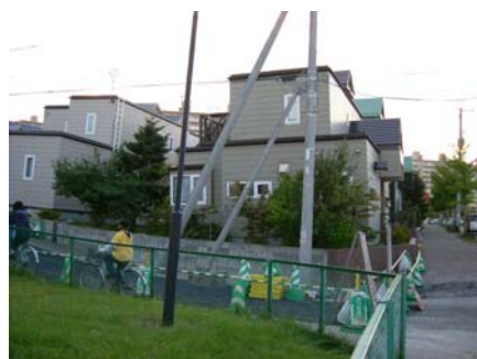
写真-2 2003 年十勝沖地震によって不同沈下した家屋(札幌市清田区)
