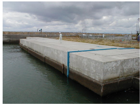
写真-1 釧路港における試験岸壁 2003年9月30日試験岸壁斜め前面から
