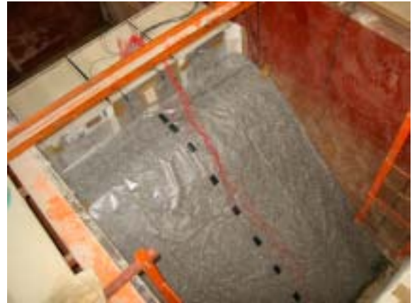
写真-4 遮水シート設置完了
