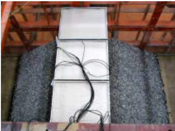
写真-2 ケーソン設置完了
