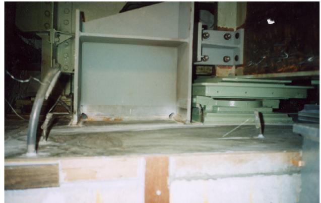
図-9 変位制限装置(桁側面)とスベリ支承
