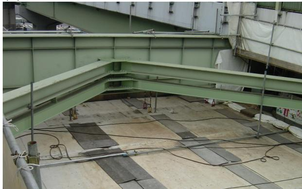
図-13 上下線連結横支材と横桁
