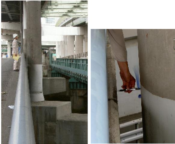
図-5 街路高欄の近接状況(橋軸直角方向)
