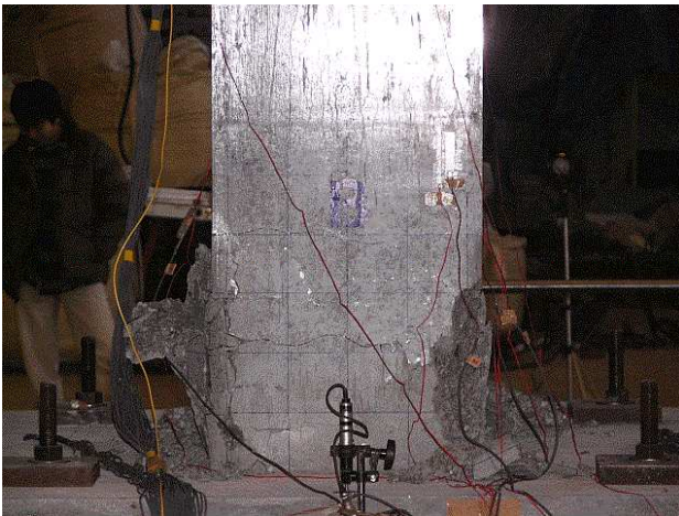
写真-1 鷹取地震波90% (三方向入力) 加振後の状況
