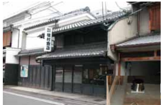
写真-3 観測対象の建物と地震計設置状況
