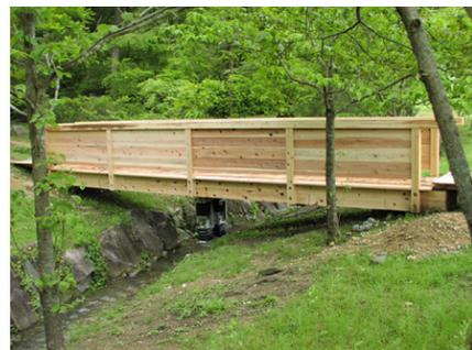
図-7 床板・手摺取付後の試験対象構造物
