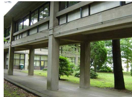
図-13 測定対象の2層RCラーメン構造物
