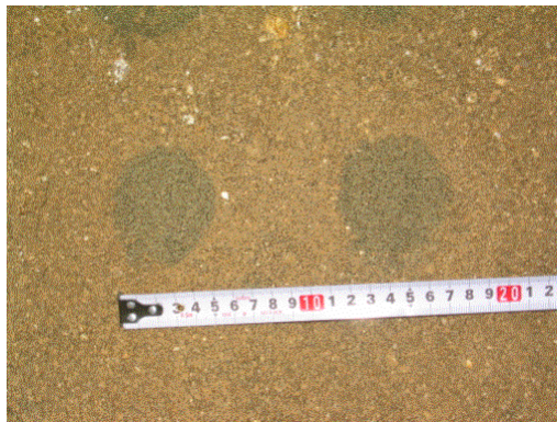
写真-2 改良杭の状況（地中）
