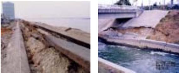
図 4 西島川表護岸の被災状況
