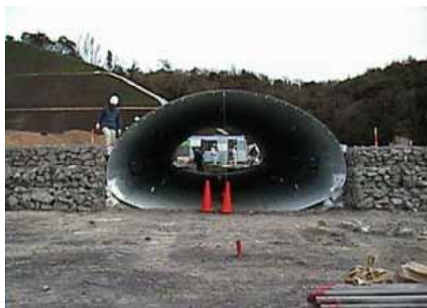
写真1 コルゲートカルバートの施工状況
