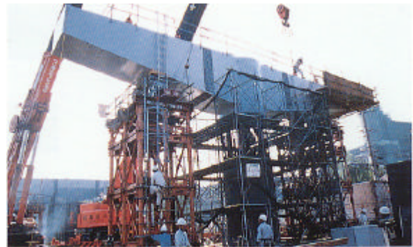
(2)鋼製梁架設状況
