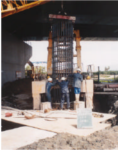
(1)場所打ち杭施工状況
