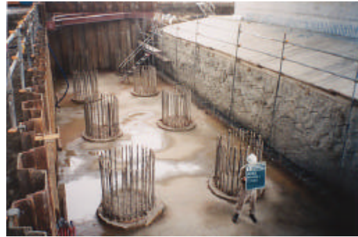
(2)増し杭完了状況
