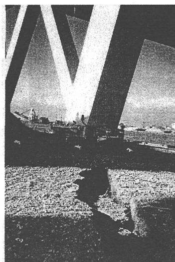
図-1 1995年阪神大震災における西宮港大橋の甲子園浜側橋脚の基礎周辺で見られた地盤亀裂 2) (右の写真は文献1からの引用)
