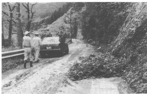
斜面崩落(国道504号線中ノ屋敷)
