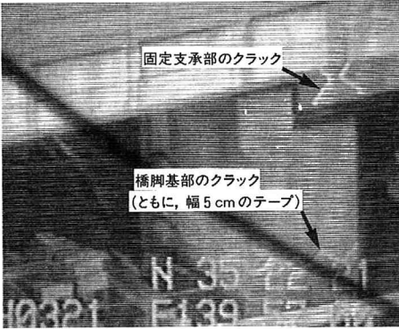
写真1 橋梁に対する震災状況の把握能力 (高度320mから撮影した可視ビデオカメラの映像)
