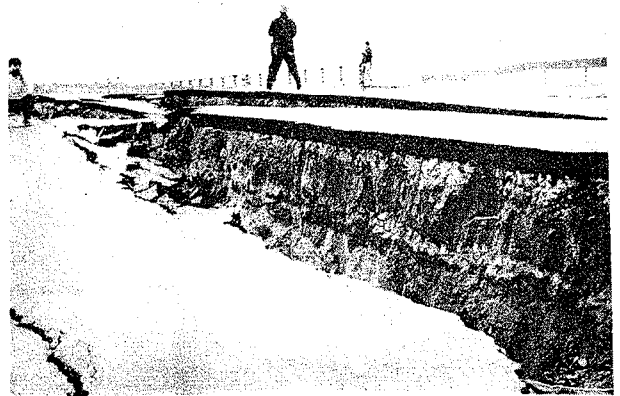
P-3 昭和大橋取付 (盛土の破壊)
