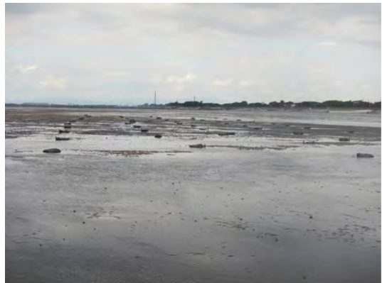
写真-3 袋状資材従来施工区（第1施工区）
