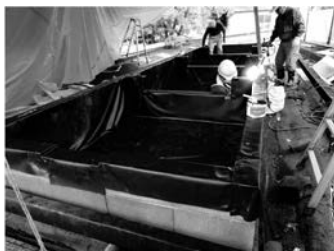
写真-4 タンク防水シート敷設状況
