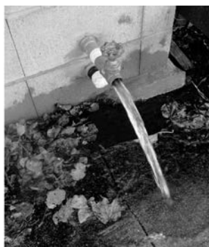
写真-3 開度調整用バルブ
