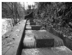
図-6 吉田川二間手魚道 (アイスハーバー型)
