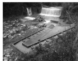
図-6 吉田川二間手魚道 (アイスハーバー型)
