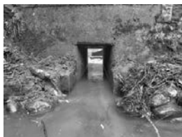
図-7 土砂・流木撤去による機能回復(二間手魚道)
