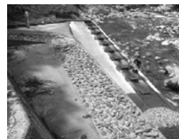
図-7 土砂・流木撤去による機能回復(二間手魚道)
