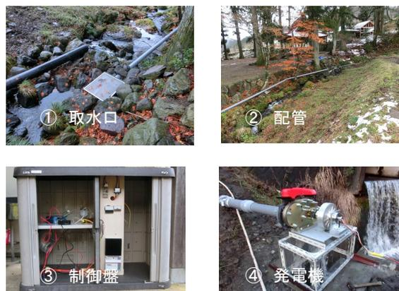
図-8 ピコ水力発電の設置状況（寒水漆洞谷）
