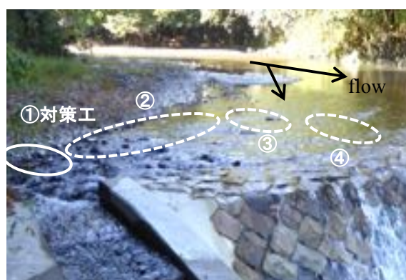
図-13 簡易床固工による対策（出水後）
