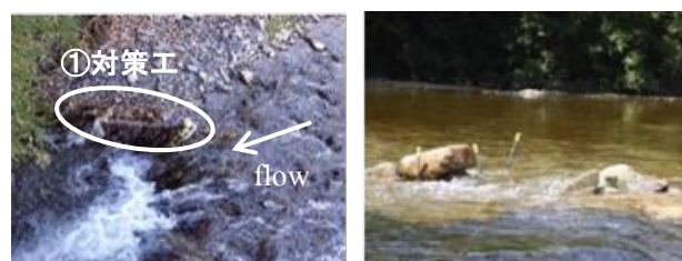
(a) 取水口上流部 (b) 差筋による固定
