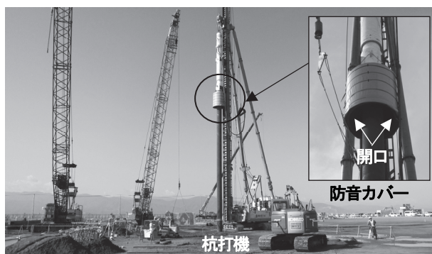
写真3 杭打機および防音カバー
