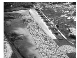
(d) 魚道入口（撤去後）
