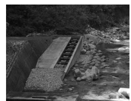
(b) 魚道入口（撤去前）
