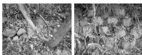
木本類の侵入 (かご多段積み) 竹の侵入 (コンクリートブロック練積)
