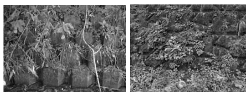
土壌厚 27cm, 水分量 74.8% 日射量 0.31kwh/m 2 /day 土壌厚 7cm, 水分量 71.9% 日射量 1.56kwh/m 2 /day
