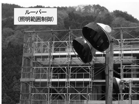
写真2 照明器具へのルーバー装着例
