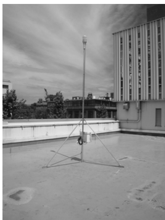
図-2 観測点B9隣の建物屋上に設置した気象観測機器
