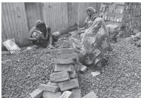
図 8 骨材用にレンガを破砕する現場
