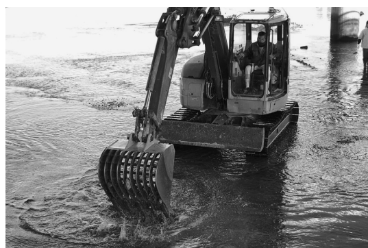
写真-1 埋没した礫を掘り出す様子
