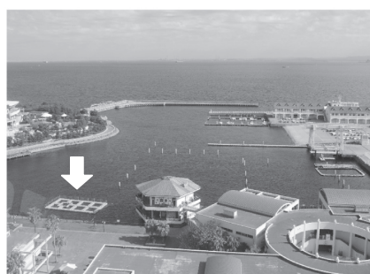
図-11 実証実験施設の設置状況
