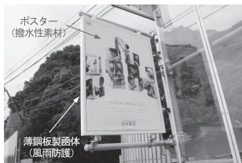
写真-12 音声安全看板の現場設置状況
