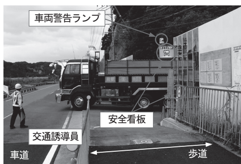
写真-9 工事車両出入口での安全対策事例
