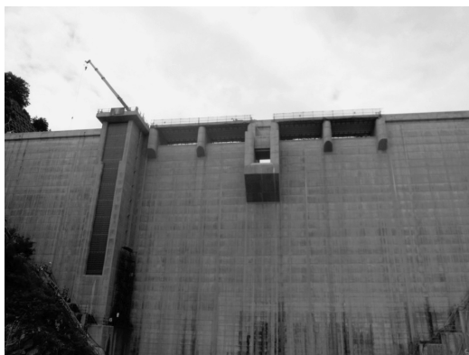
写真-1 重力式コンクリートダム
