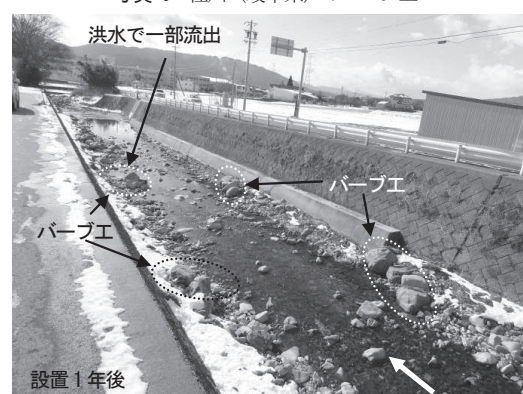
写真-7 梅谷川（岐阜県）のバーブ工
