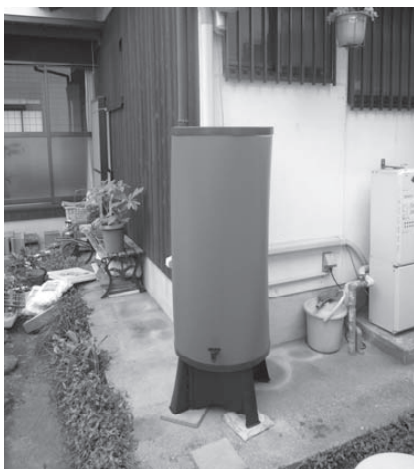
写真-1 雨水貯留タンク
