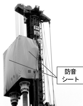
写真4 モーター部の防音シート囲い状況
