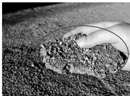
写真5 防塵材により膜状に固まった土の表面
