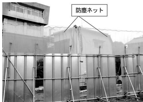
写真-6 現場近接の民家前の防塵ネット設置例
