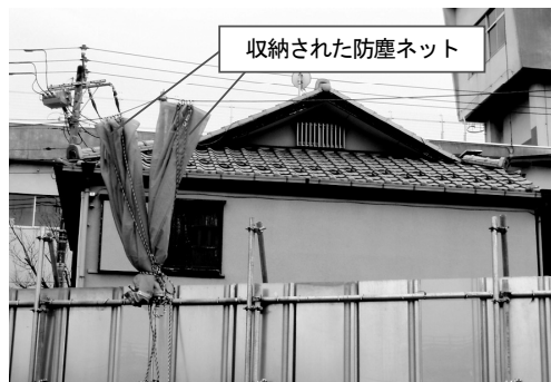
写真-7 防塵ネットの巻き取り状況
