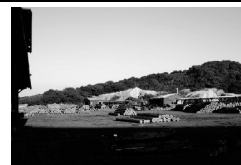
写真-4 県森連御坊に設置された関連設備
