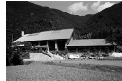
写真5 関連設備導入施設
