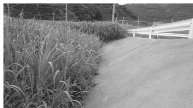
写真-12 施工後1ヶ月
