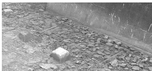
写真-11 根固工施工
