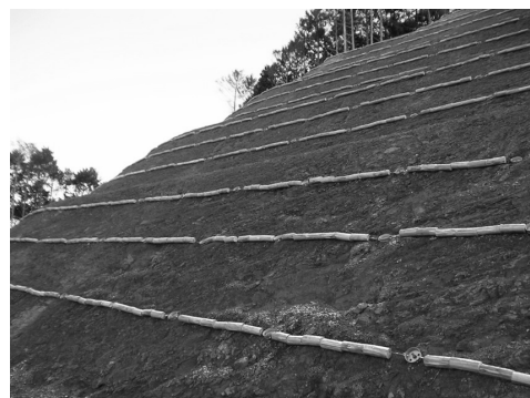
写真-1 ウッド筋工施工完成
