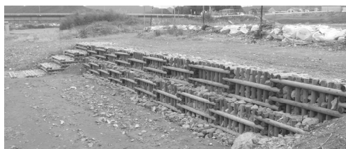
写真-10 護岸工施工
