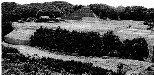
図-7 造成時の倉津団地
