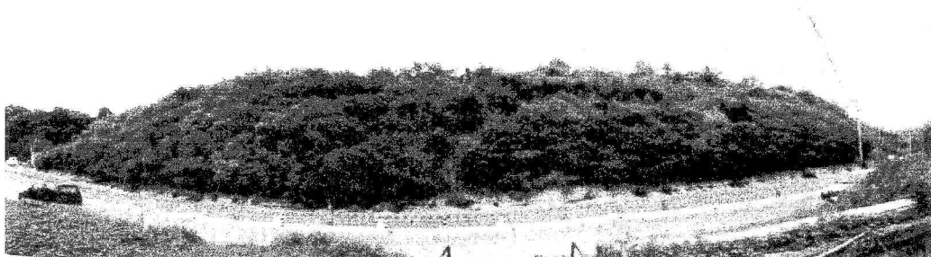
写真-10 施工後の斜面状況 (約2年3ヶ月経過)
